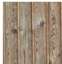
Bardage à couvre joints
